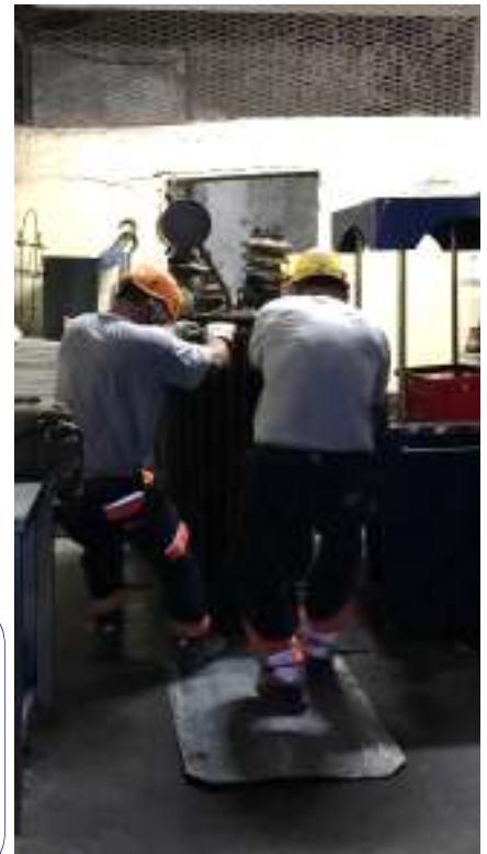
LAVORO DI SOSTITUZIONE TRASFORMATORE PRESSO CABINA DI VIA NAZIONALE- ROMA.
