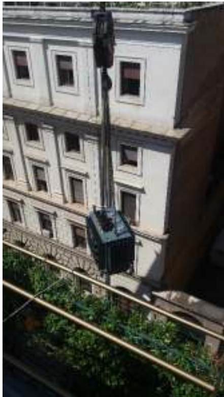
LAVORO DI SOSTITUZIONE TRASFORMATORE PRESSO CABINA DI VIA NAZIONALE- ROMA.
