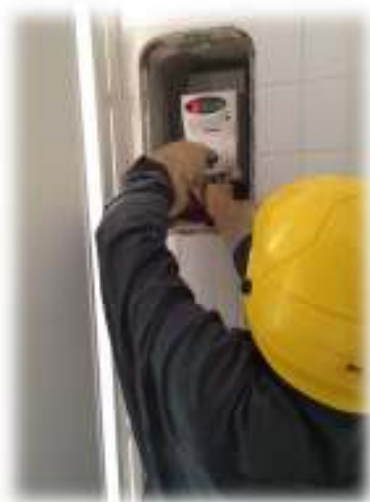
ATTIVITA' DI SOSTITUZIONE CONTATORE ELETTRICO.
