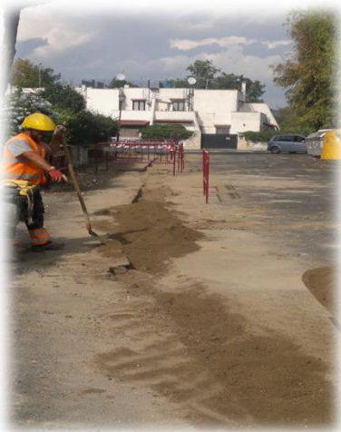
LAVORI ENEL DI SCAVO E POSA CAVO LADISPOLI (RM)
