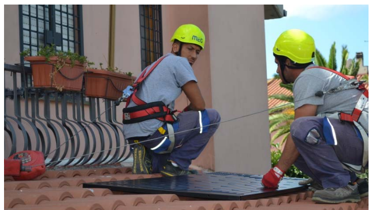
LAVORI INSTALLAZIONE IMPIANTO TERMICO DINAMICO
