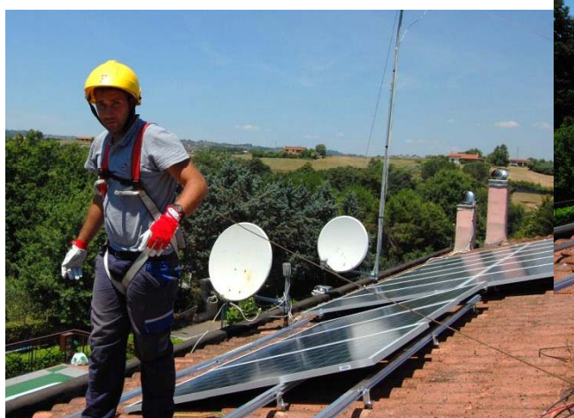
LAVORI INSTALLAZIONE IMPIANTO FOTOVOLTAICO
