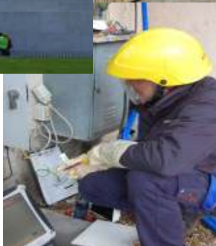
LAVORI DI GESTIONE UTENZA SOTTOTENSIONE - FIUMICINO
